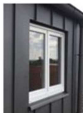
MONTAGE VON FENSTER UND TÜREN
